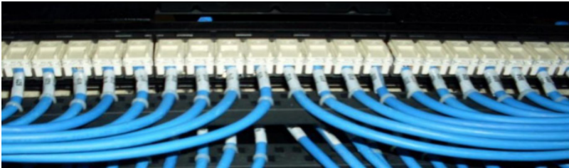
Figura 15: Exemplo de cabos fixados no guia traseiro do patch panel
